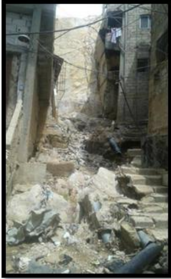
الصورة(20): الحطام الصخري، وتدمير قاعدة الجرف الاسمنتية، وتكسير أنابيب الصرف الصحي. يوم (2018/5/9)م.
