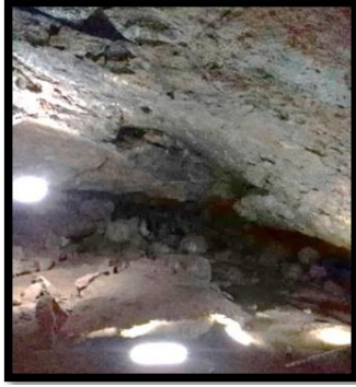
الصورة (41): انهيار كتلة ضخمة من السقف.
