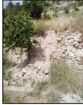
الصورة رقم (13) انهيار جزء من جدار حجري، شيد لحماية الأراضي الزراعية من الانجراف.
