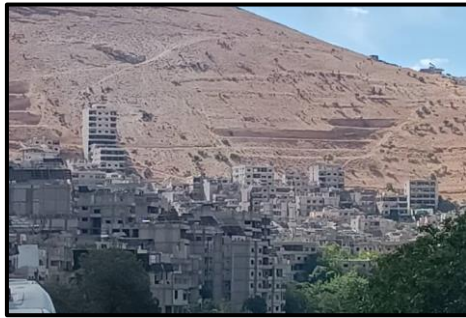
الصورة (23) التخفيف من شدة انحدار سفح جبل الزهري، بإنشاء المصاطب.
