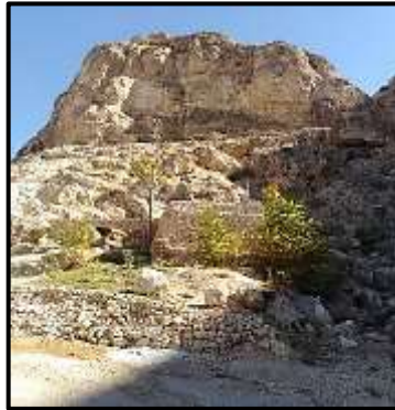
الصورة (19) خزان تجميع مياه عين كوشل، مشروع أبو جندل، يشير السهم إلى بعض الكتل الصخرية التي تعلو المنشأة.
