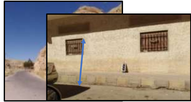
الصورة (1) الحد الذي بلغه ارتفاع سيل عام (1968) م عند مدخل مخنق اسكفتا.
