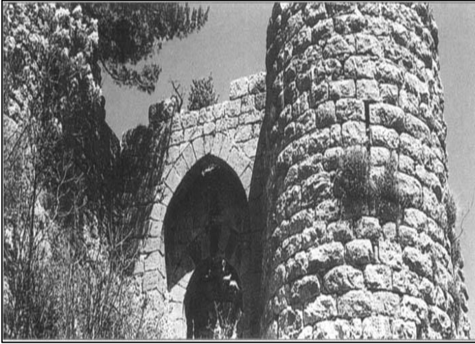
الشكل 3: المدخل الرئيس لقلعة ساروندكار. (1)
