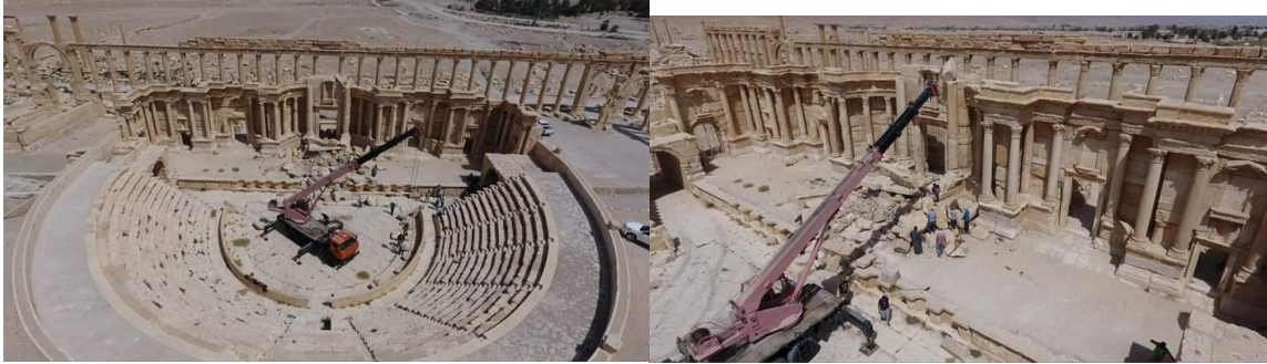
صورة (1): أعمال ترميم واجهة المسرح الأثري (موقع مديرية الآثار والمتاحف)
