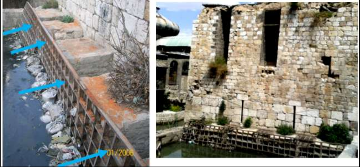
(الصورة 2-أ) الواجهة الغربية لطاحونة القلعة
