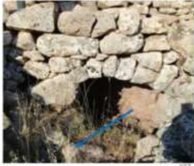
(الصورة 16) فتحة مغطّنة لخروج الماء (عن مديرية آثار السويداء)
