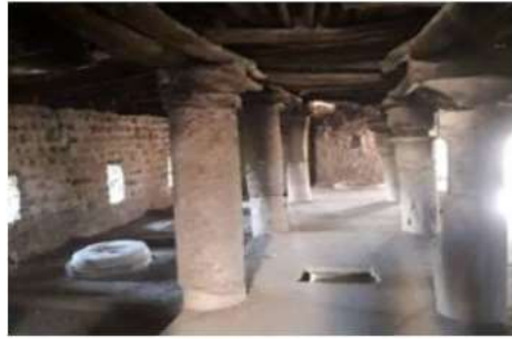
(الصورة 30) الطاحونة من الداخل (أعمدة حمل السقف) (عن أرشيف منصور)
