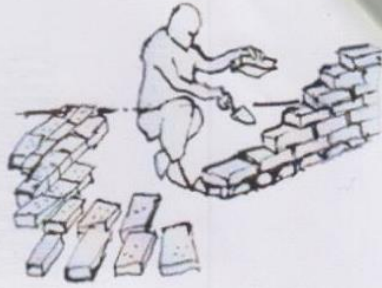
الشكل ١١ رصف الجدار وإغلاق الفواصل.
