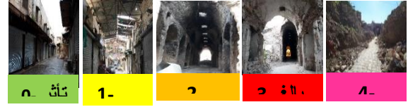
الشكل (12) تقييم الضرر في خمس درجات، بتحديد السمات الرئيسية للمبنى
