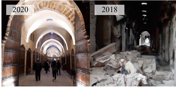
الصورة(13) سوق السقراطية /1/ تم ترميمه من قبل الأغا خان المصدر: زيارات الباحث
