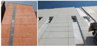
الصورة (15) الألواح الخرسانية المسلحة بالصوف الزجاجي.
