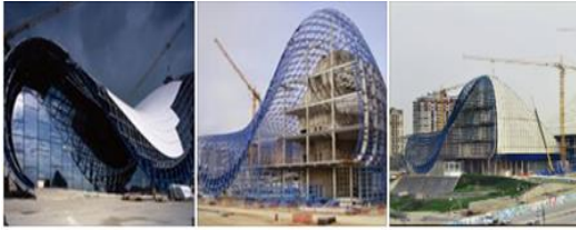
الشكل (18): مراحل تنفيذ مبنى حيدر علييف [11ص82]
