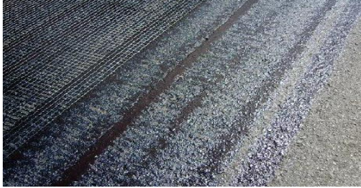
الشكل (5) تطبيق Geotextile mesh على الطرقات
