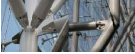
الشكل (20) وصل المفصل في العمود الشجري (Boake, 2011, p. 21)
