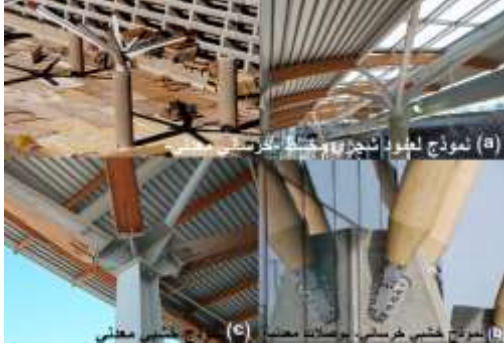
الشكل (25) نماذج مختلفة لأعمدة شجرية مختلفة (Steel Structures Education Foundation, 2006) (Boake, 2011, p. 33)
