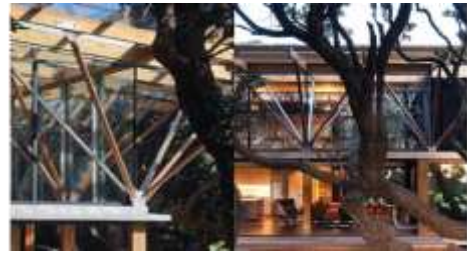
الشكل (4) نموذج الهيكل الشجري المتمفصل في المبنى السكني Under Pohutukawa (Barrie, pp. 36,38)
