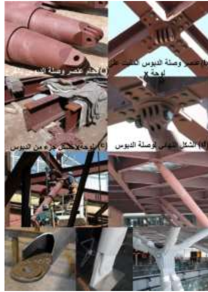
الشكل (19) المراحل المتسلسلة لاستخدام وصلة الدبوس في العمود الشجري (Boake, 2011, pp. 16,36)
