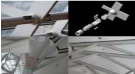
الشكل (21): نموذج من نماذج الوصلات المخفية في الأعمدة الشجرية (Boake, 2011, p. 18)
