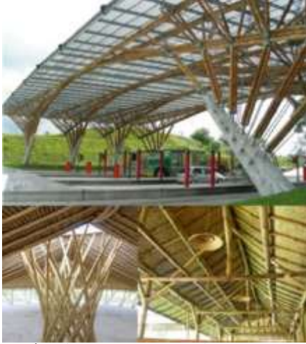
الشكل (24) نماذج لاستخدام القصب في الأعمدة الشجرية (Widyowijatnoko & Harries, 2020, pp. 586, 570,)
