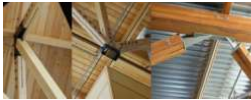
الشكل (22) الوصلات المعدنية في التفريعات الخشبية
