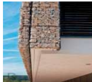
صورة 2/ تبين استخدام الأحجار ضمن الأقفاس للإكساء الخارجي بأبعاد صغيرة للقفص [13] .
