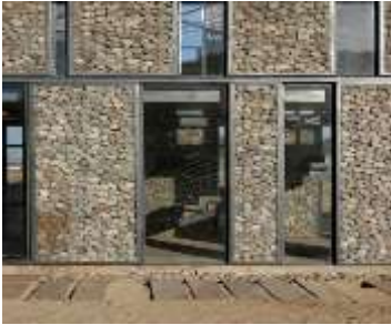
صورة 3/ استخدام الأحجار ضمن الأقفاس للإكساء الخارجي بأبعاد كبيرة للقفص [13] .
