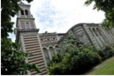
الصورة (4) ترميم قصر رامو للمعارض. المصدر 4
