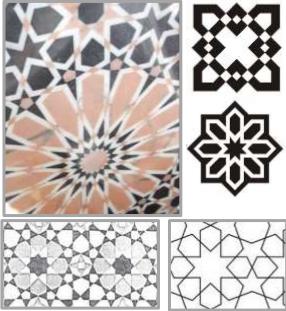
الشكل (9) فوق يسار: صورة لألواح الرخام المشقف وأطباق الزخارف النجمية المستخدمة بكثرة في الدور التقليدية الدمشقية - (فوق يمين - تحت) رسوم توضيحية لنماذج من الزخارف الهندسية والأشكال النجمية المستخدمة في تقنيّة الرخام المشقف.
