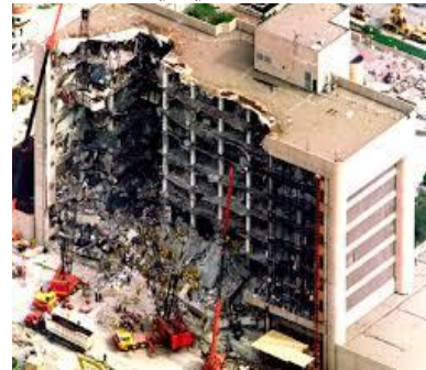
الشكل (2) المبنى الحكومي في مدينة أوكلاهوما. [1]
