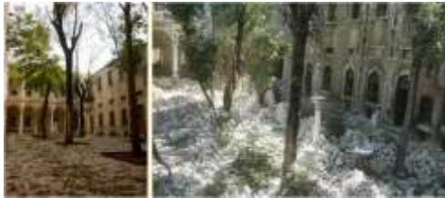
ب: مدرسة الشيباني، قبل الترميم وبعده.
