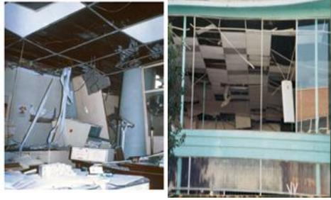
الشكل(6): أثار انهيار الاسقف المستعارة. [3]
