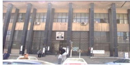
الصورة(13) عدلية حلب، تظهر فيه الأعمدة معيقة للواجهات.(مصدر الصورة: Google Images)
