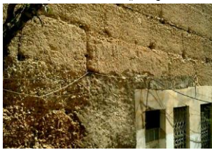
الصورة (3)، جدار خارجي من التربة المدكوكة لمنزل في دمشق {العمارة التقليدية المتوسطة، 2005، 2}.
