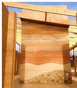
الصورة (1): جدار مبني من التربة المدكوكة يبين الإمكانيات الجمالية لإظهار طبقات الدك، {Easton, 2007, 30}.
