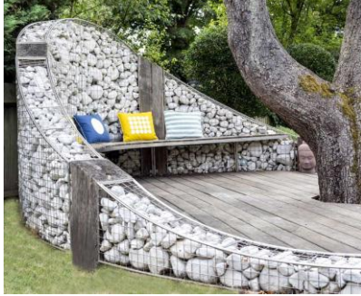
صورة (5) تبين استخدام gabion wall كسور منخفض
