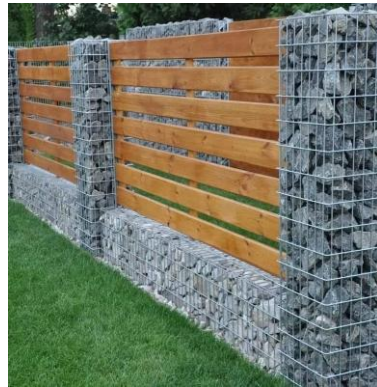
الشكل (4) تبين استخدام gabion wall
