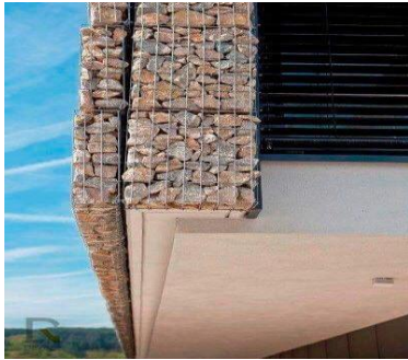
الشكل (1) تبين استخدام gabion wall للإكساء الخارجي بأبعاد صغيرة للقفص
