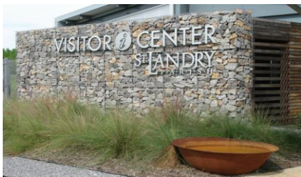
الشكل (6) تبين استخدام gabion wall
