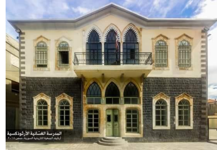
الصورة (5) الواجهة الجنوبية بعد الترميم المصدر (18)
