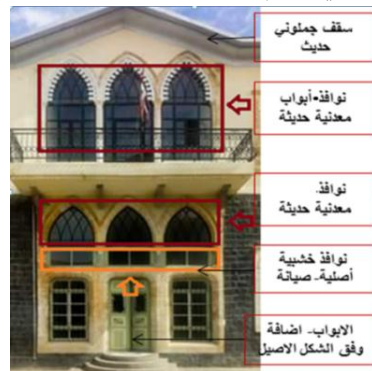
الصورة (6) المعالجات التي تمت على الواجهة (20)
